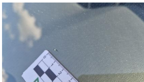
Fot. 32 Szyba czołowa ogrzewana - Rysa/odprysk 1
