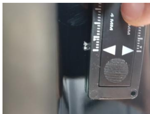
Fot. 48 Próg lewy (Rysa/Odprysk)
