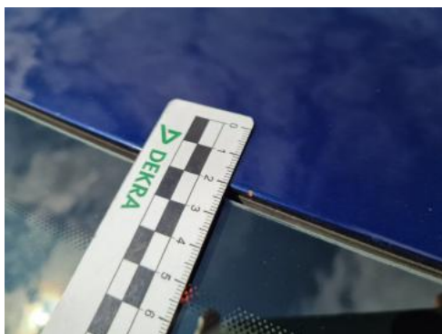
Fot. 53 Dach (Inne)
