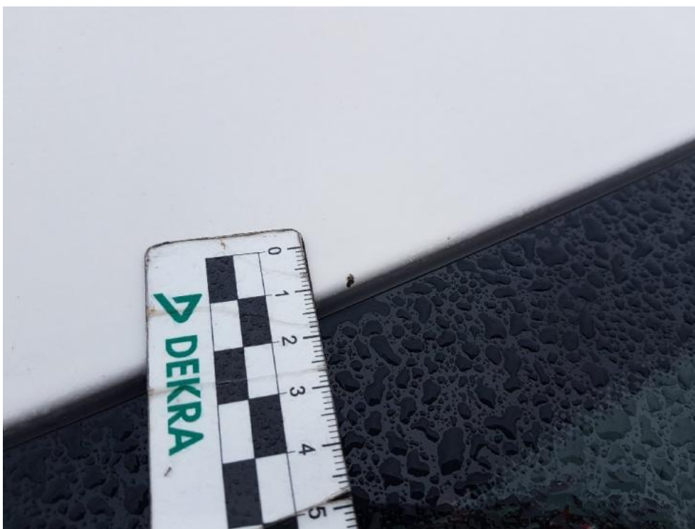
Fot. 33. Dach (Rysa/Odprysk)
