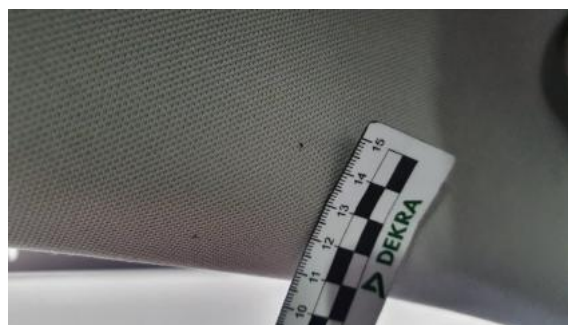
Fot. 30 Podsufitka (Inne)
