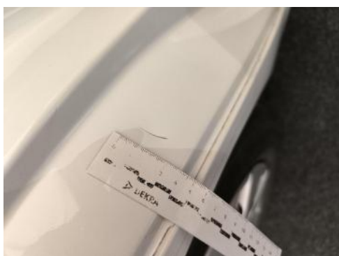
Fot. 45 Próg P - zdjęcie pogłądowe 2
