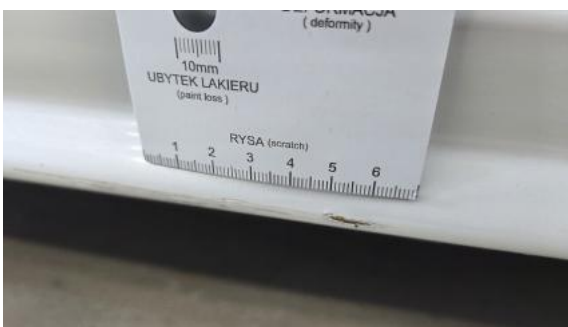
Fot. 47 Próg P - Rysa/odprysk 1
