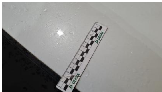
Fot. 42 Dach - Rysa/odprysk 1
