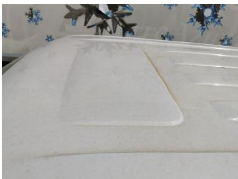
Fot. 41 Dach - Inne 1
