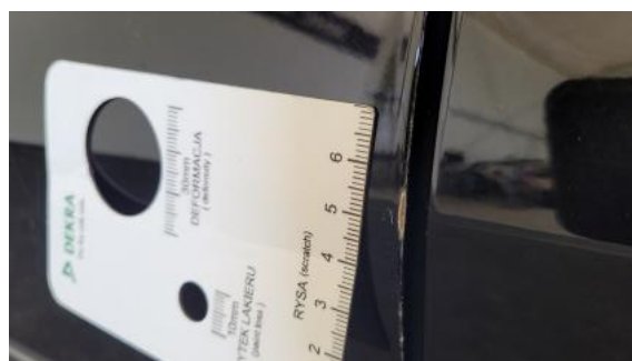
Fot. 36 Drzwi przed L - Rysa/odprysk 1
