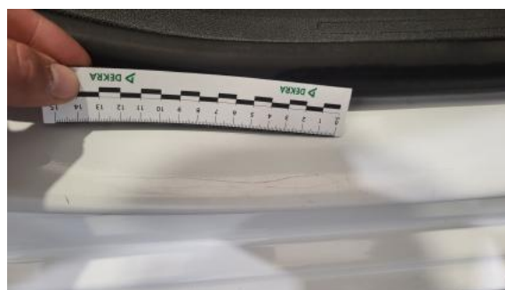
Fot. 38 Próg P - Rysa/odprysk 1
