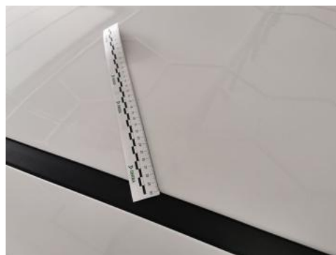
Fot. 50 Dach - zdjęcie pogłądowe 1
