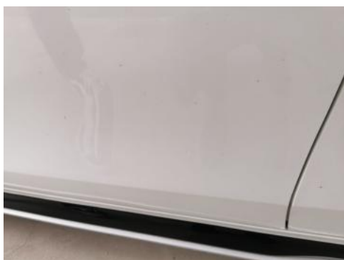
Fot. 55 Drzwi przed L - Inne 1
