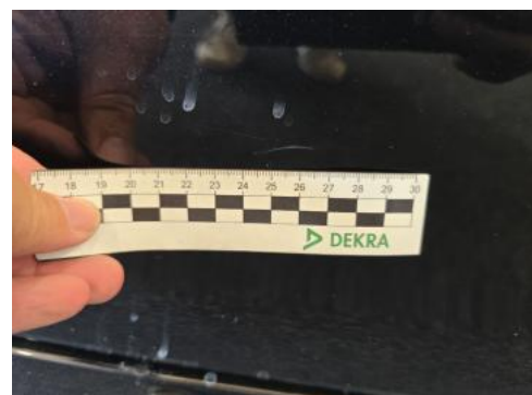
Fot. 72 Drzwi przed L - zdjęcie poglądowe 2
